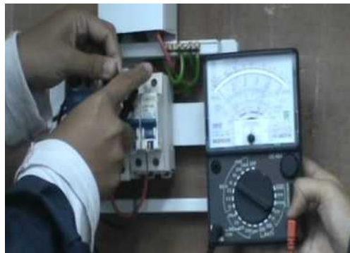
Gambar cara pengujian isolasi kabel
